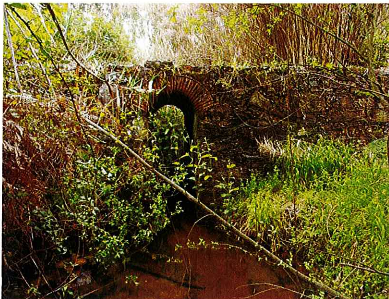
INFRAESTRUTURA NA FONTE DAS SENHORAS – ÁGUA FÉRREA – CASAL LAGAR DO RIO
